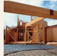
Garage door header.
